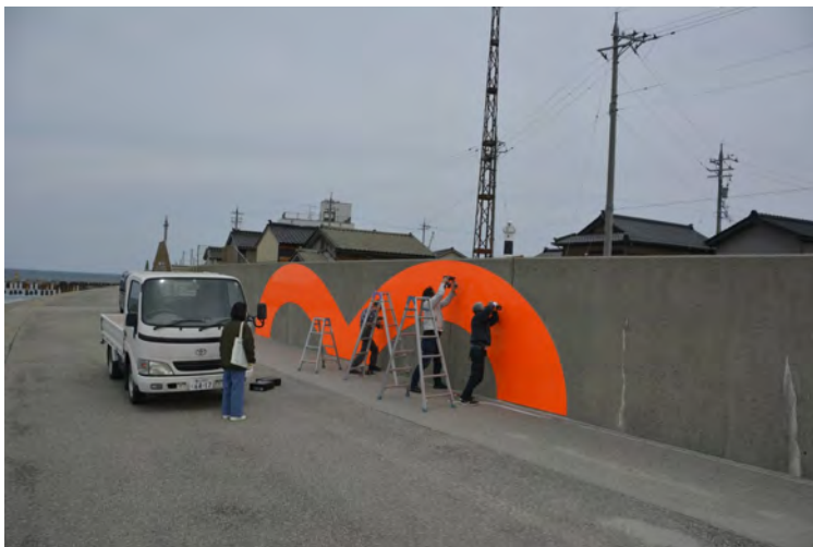
4月24日 黒部市生地海岸にパネルが設置された
